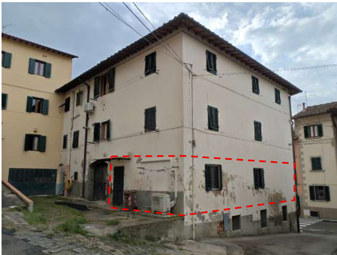
FOTO 3 Vista dalla Via dei Morelli – Facciata posteriore e prospetto laterale
