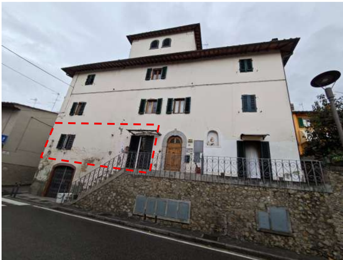
FOTO 1 Vista dalla via Chiantigiana - facciata principale
